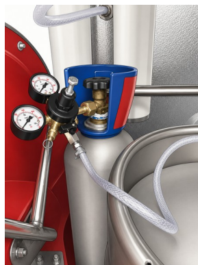
Compartimento térmico e regulador de pressão do gás CO 2 .
